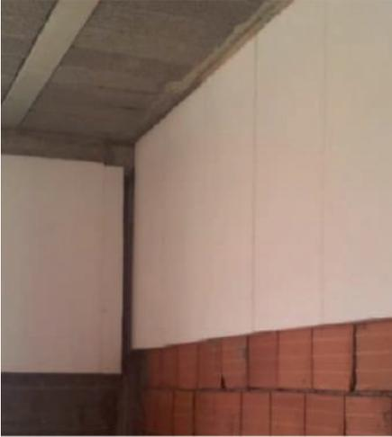
Figure 30.- Placement des plaques de l'EPS.
