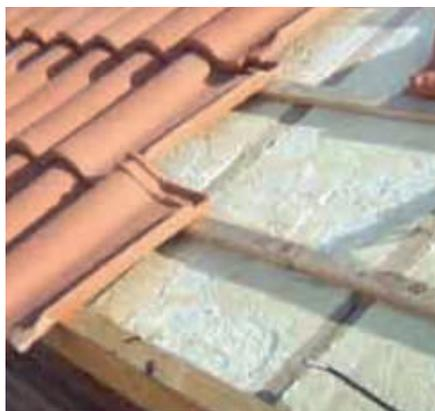
Figure 24.- Mise en place des tuiles (Source: ANAPE)
