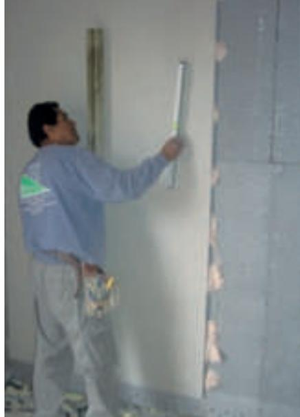
Figure 43.- Fixation de la plaque de plâtre et vérification de niveau. (Source: ANAPE)
