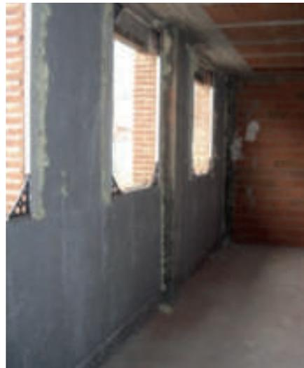
Figure 40.- Paroi totalement isolée par l'intérieur. (Source: ANAPE)
