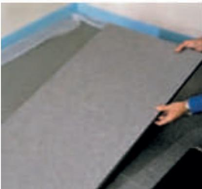
Figure 48.- Panneaux isolants EPS
