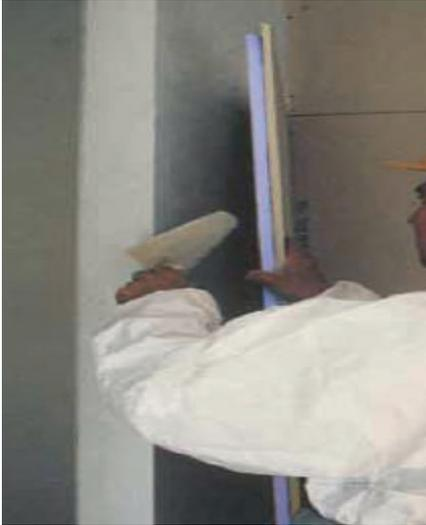
Figure 38.- Isolation par l'intérieur avec du XPS et une plaque de plâtre (Source: AIPEX)
